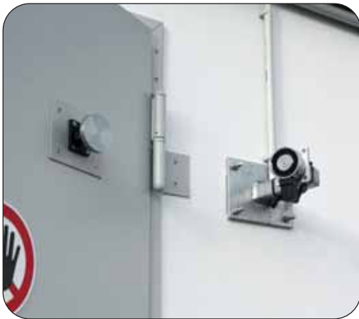
Türfeststellanlage mit allgemeiner bauaufsichtlicher Zulassung
